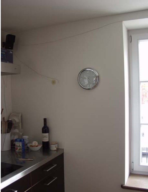
Bild 4.3.1: Wärme fluss sensor in der Küche an der Nordwand. Position: ca. 55 cm von der Ecke und ca. 65 cm von der Fensterleibung, 160 cm über dem Boden
