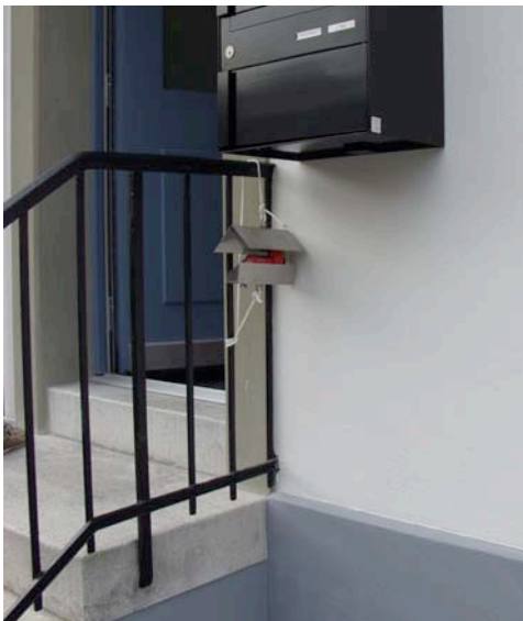
Bild 5.3: Ecolog Temperatur- Luftfeuchtigkeitsmessgerät strahlungs- und witterungsgeschützt auf der Nordseite der Liegenschaft
