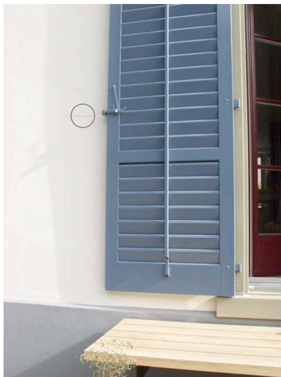
Bild 5.6: U-Wert Messtelle Süd aussen, Thermoelement aufgeklebt auf der Aussenwand
