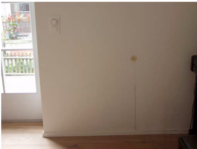
Bild 4.3.2: Wärme fluss sensor im Wohnzimmer an der Süd wand. Position: Mitte Wand (182 cm), 80 cm über dem Boden
